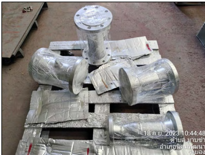
ภาพตัวอย่างการนำพลาสติกเทปใสพัน Spool piece และ Equipment
